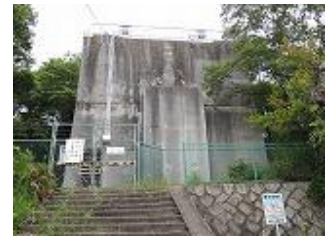
が通し見により配水池の盗採が良くなった
