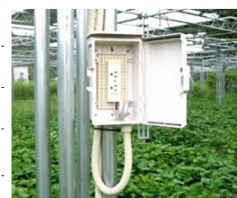
災害時地域で使える非常用電源(各 1.5KW)
